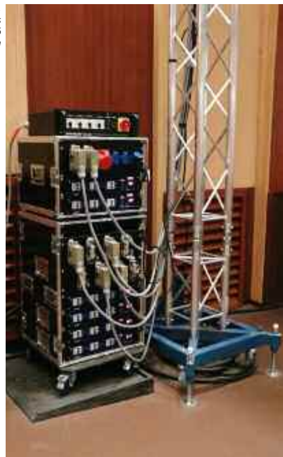
Dimmer, direkt egység és motorvezérlő trió a nézőtéren
